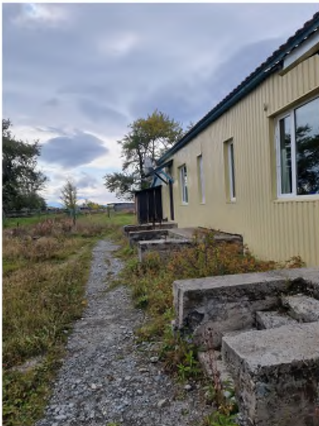
Фото 5,6. Фото вдоль главного фасада. Видно: отсутствие отмостки, разрушение поверхностного слоя бетона на крыльцах, разрушение бетона дорожек, отсутствие металлических доборов на карнизном свесе кровли.
