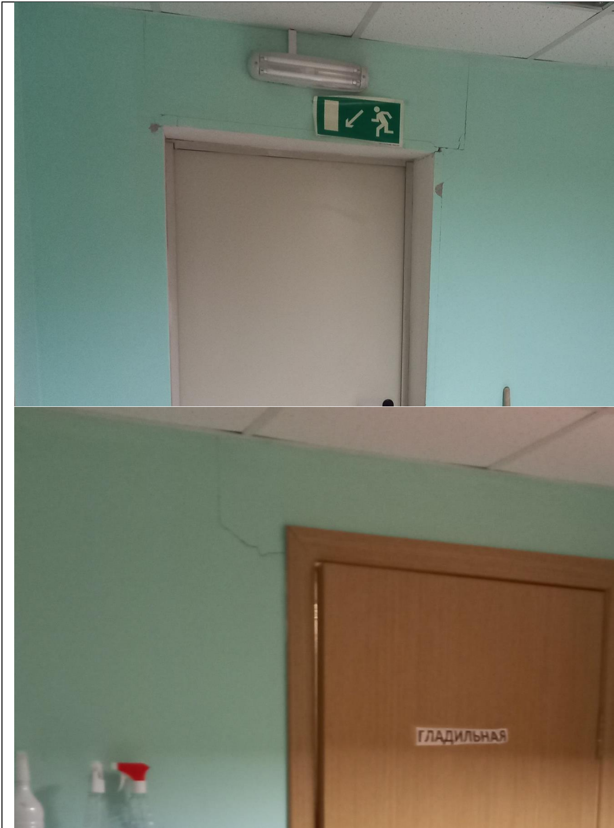
Фото 15. Помещение №6 (Коридор №2). Трещины по отделочному слою стен наклонной направленности.
