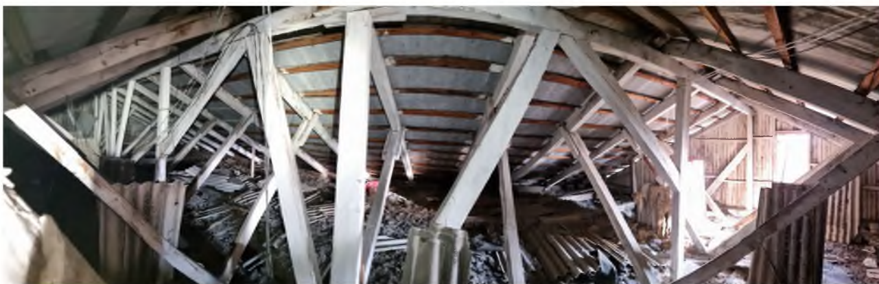
Фото 7. Чердак блока 1, видно что все доски кроме обрешетки обработаны известью. При капитальном ремонте 2015 года менялась крыша на профнастил НС35, при этом демонтированный старый шифер не убран.
