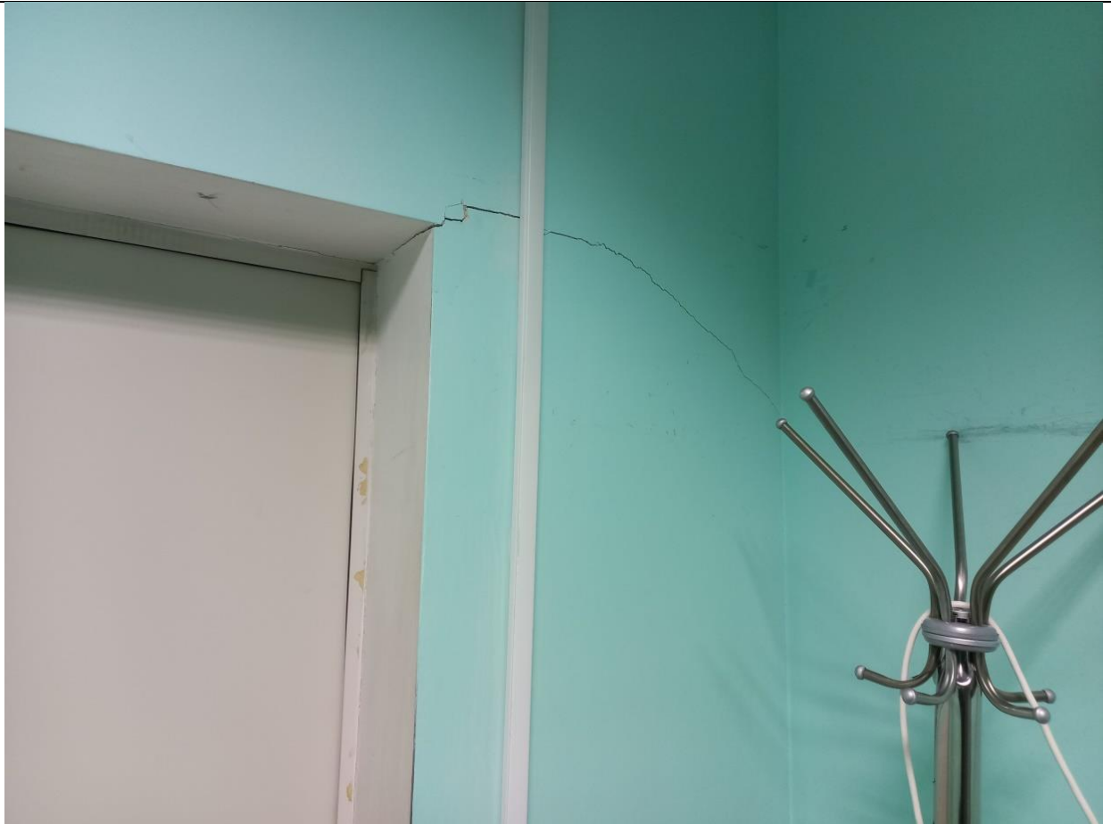
Фото 9. Помещение №1(Холл). Трещина по штукатурному слою стены наклонной направленности.
