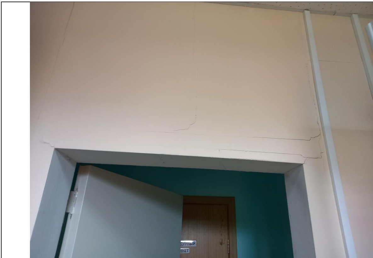
Фото 12. Помещение №3 (Кабинет для хранения медикаментов, не содержащих наркотич. в-в.). Многочисленные трещины по окрасочному слою стены, различной направленности.
