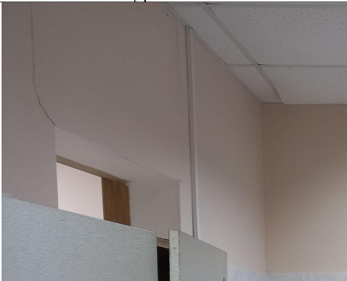
Фото 7. Помещение №10 (Бытовое помещение). Трещины по окрасочному слою стены наклонной направленности
