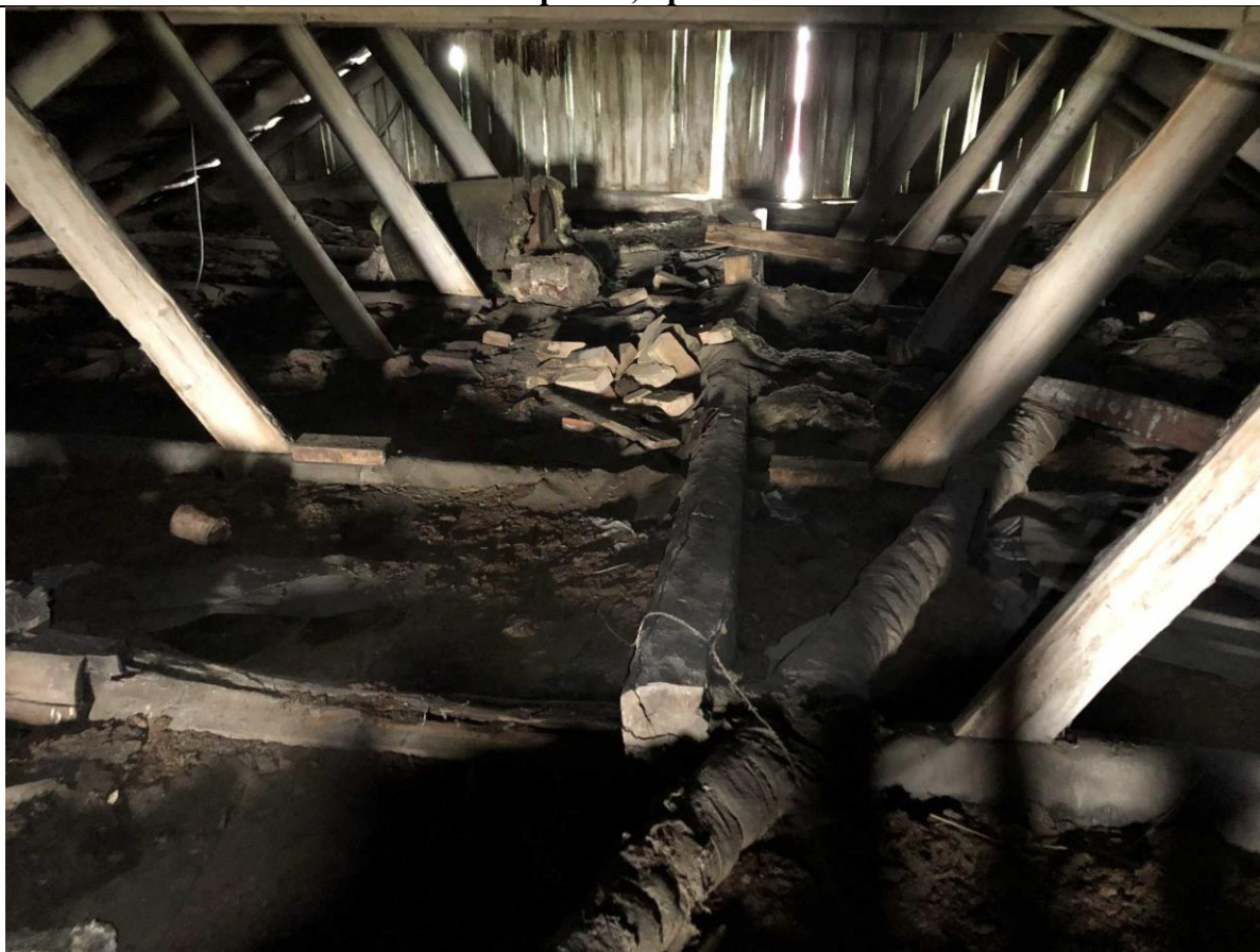
фото 3. Чердачное пространство. Зазоры между досками фронтона.
