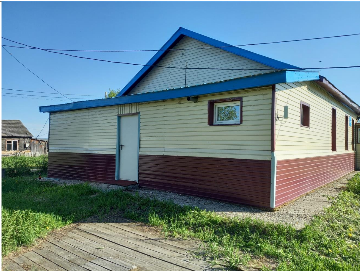
Фото 1. Общий вид фасада здания в осях В-А. Разрушение бетонной отмостки по периметру здания.
