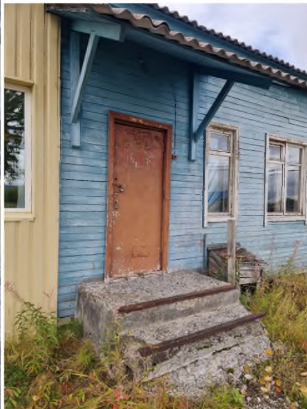
Фото 5,6. Фото вдоль главного фасада. Видно: отсутствие отмостки, разрушение поверхностного слоя бетона на крыльцах, разрушение бетона дорожек, отсутствие металлических доборов на карнизном свесе кровли.
