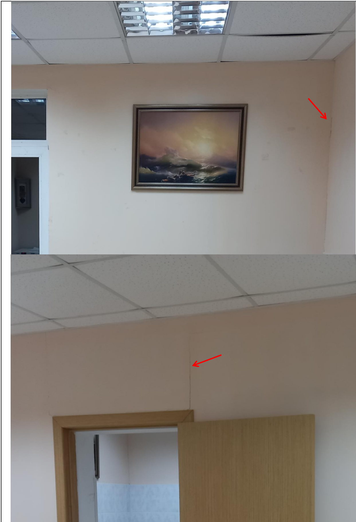
Фото 10. Помещение №11 (Кабинет). Нарушение окрасочного слоя стен. Трещины по окрасочному слою стен, вертикальной направленности.
