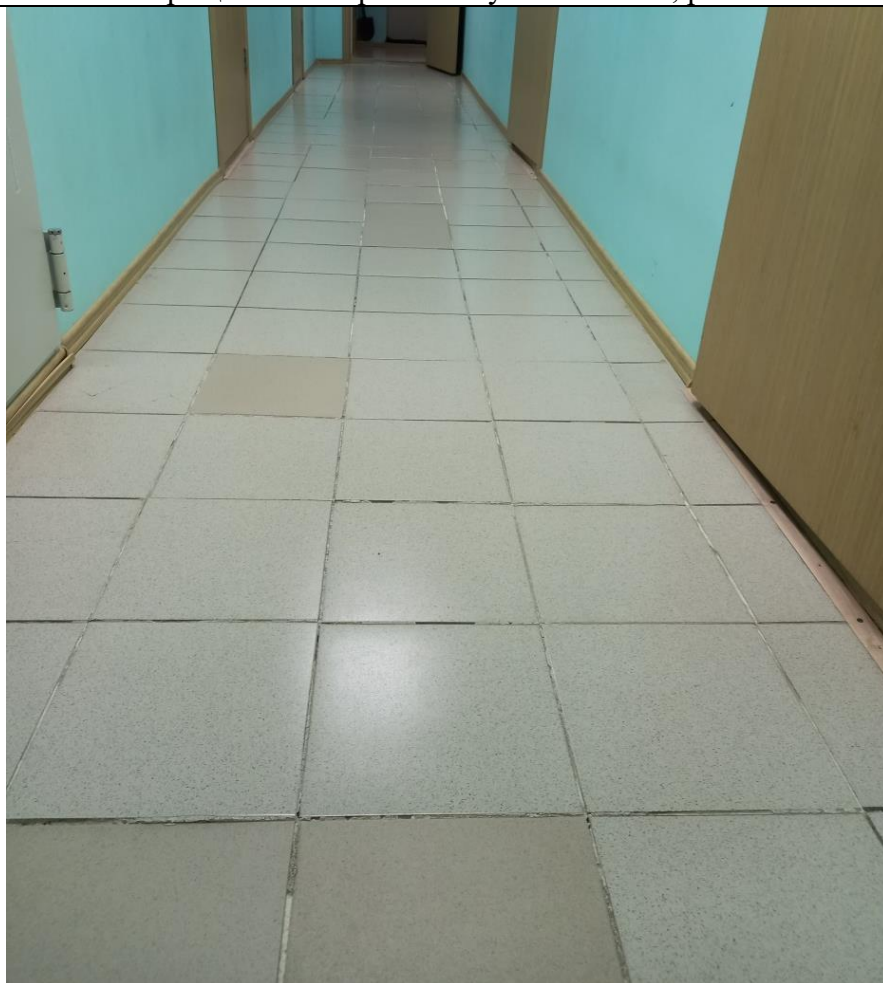
Фото 13. Помещение №2 (Коридор №1). Нарушение заполнения швов между плиток напольного покрытия, ослабление отдельных плиток.
