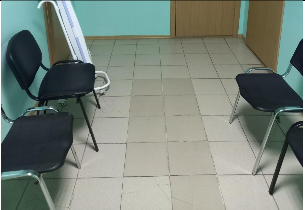
Фото 8. Помещение №1 (Холл). Трещины и сколы напольного покрытия из керамической плитки.
