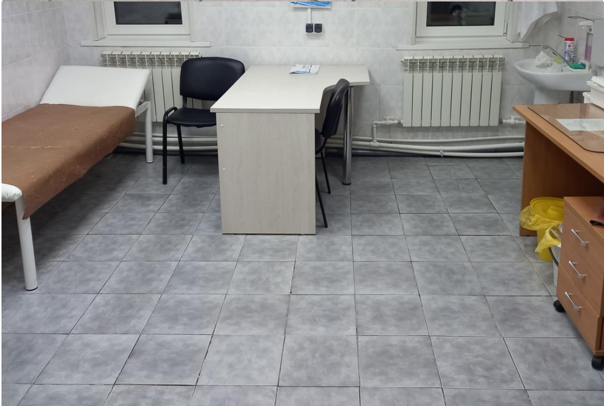
Фото 14. Помещение №6 (Коридор №2); Помещение №12 (Прививочный кабинет). Нарушение заполнения швов между плиток напольного покрытия, сколы и ослабление отдельных плиток.
