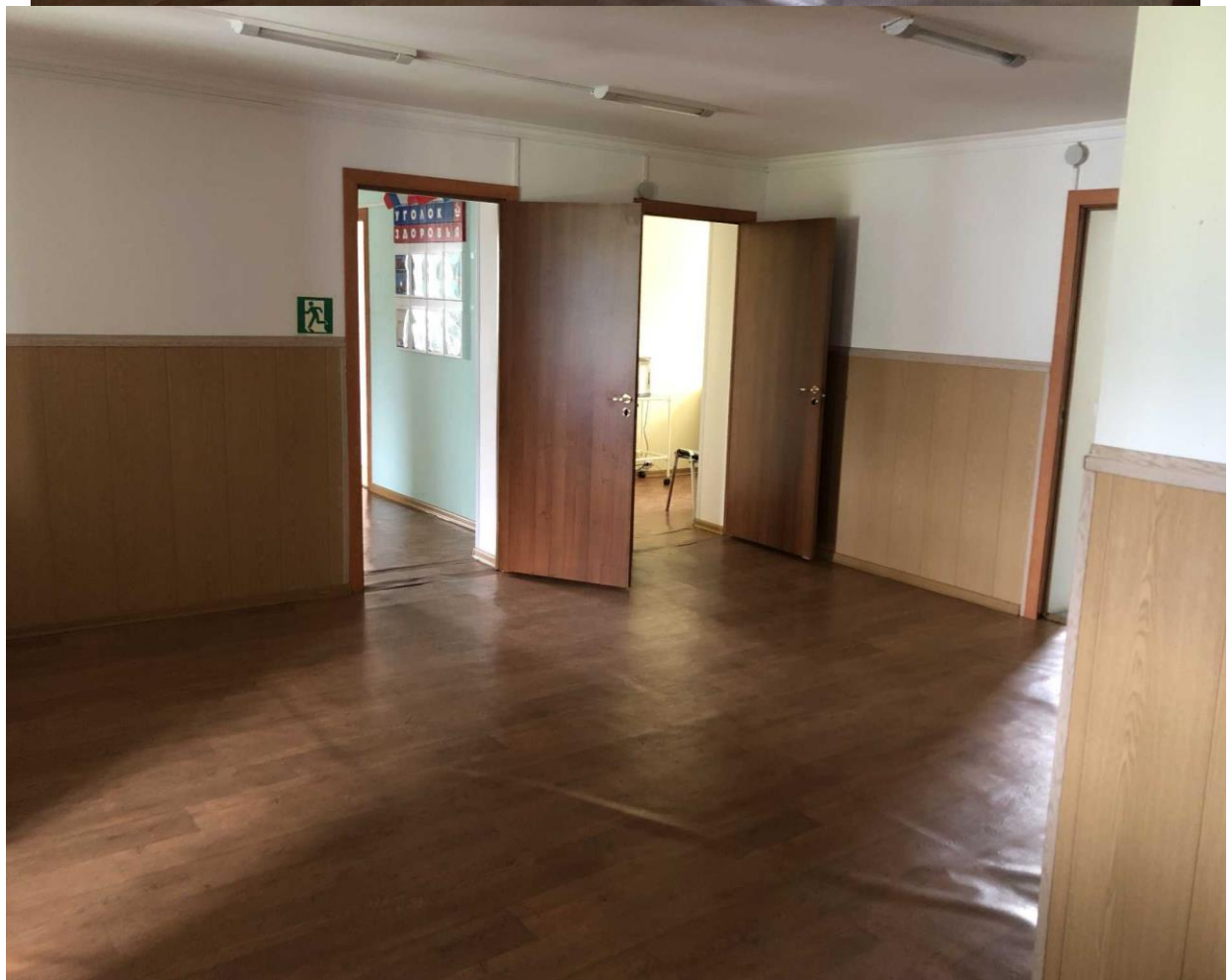
фото 5. Внутреннее помещение. Вздутия линолеумного покрытия пола.
