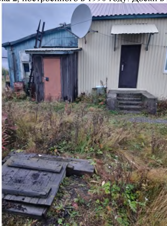
Фото. 9 Колодец к которому подключены к центральной системе отопление и хвс. Накрыт Двумя крышками из дерева. С учетом практики в с. Ачайваям так теплее.
