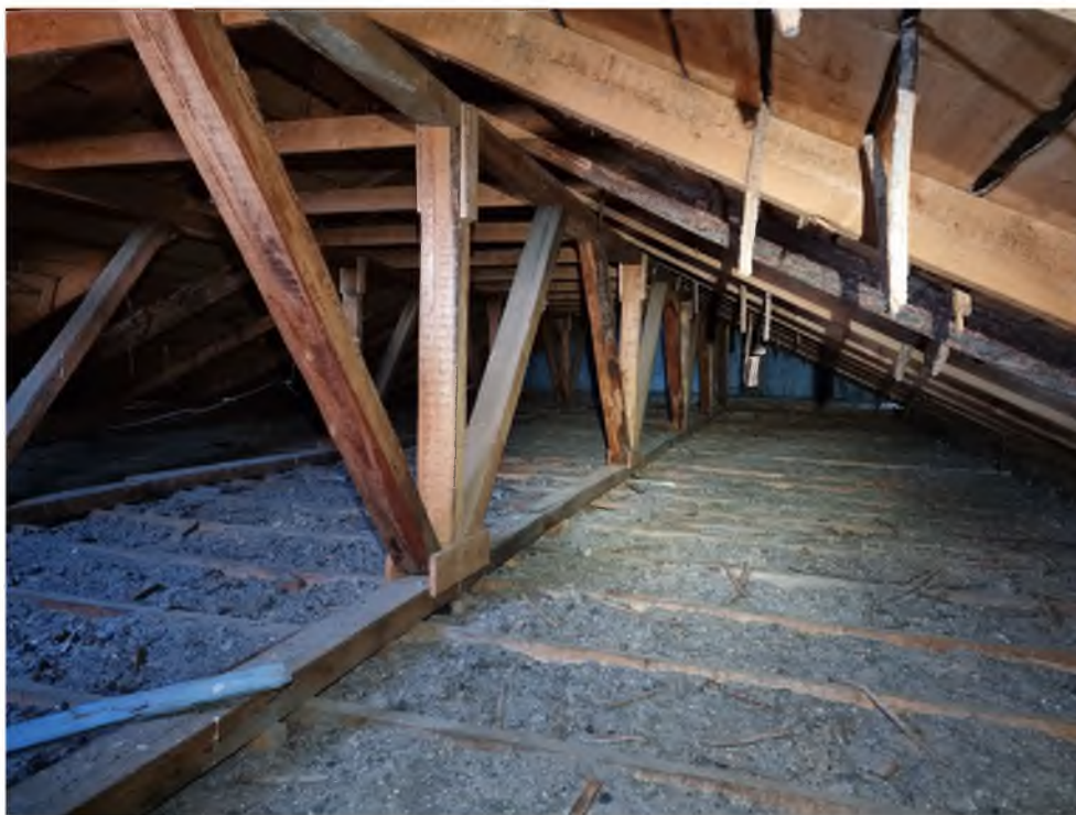
Фото 8. Чердак блока 2, построенного в 1990 году. Доски в хорошем состоянии.
