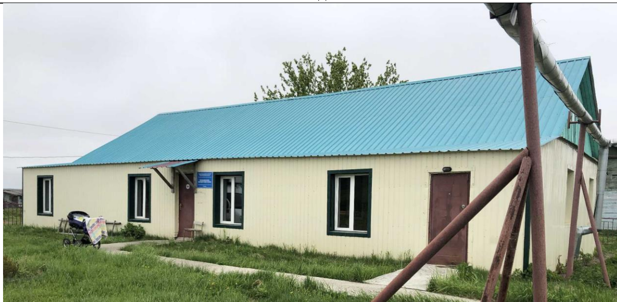
фото 1. Общий вид фасадов в осях 1-5 и А-Г. Отсутствие отмостки здания. Общий физический износ дверных полотен.
