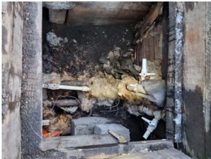
Фото. 9 Подключение к стальным отоплению и хвс D60 трубам, пластиковых D40 отопления, d25 хвс - ФАПа.
