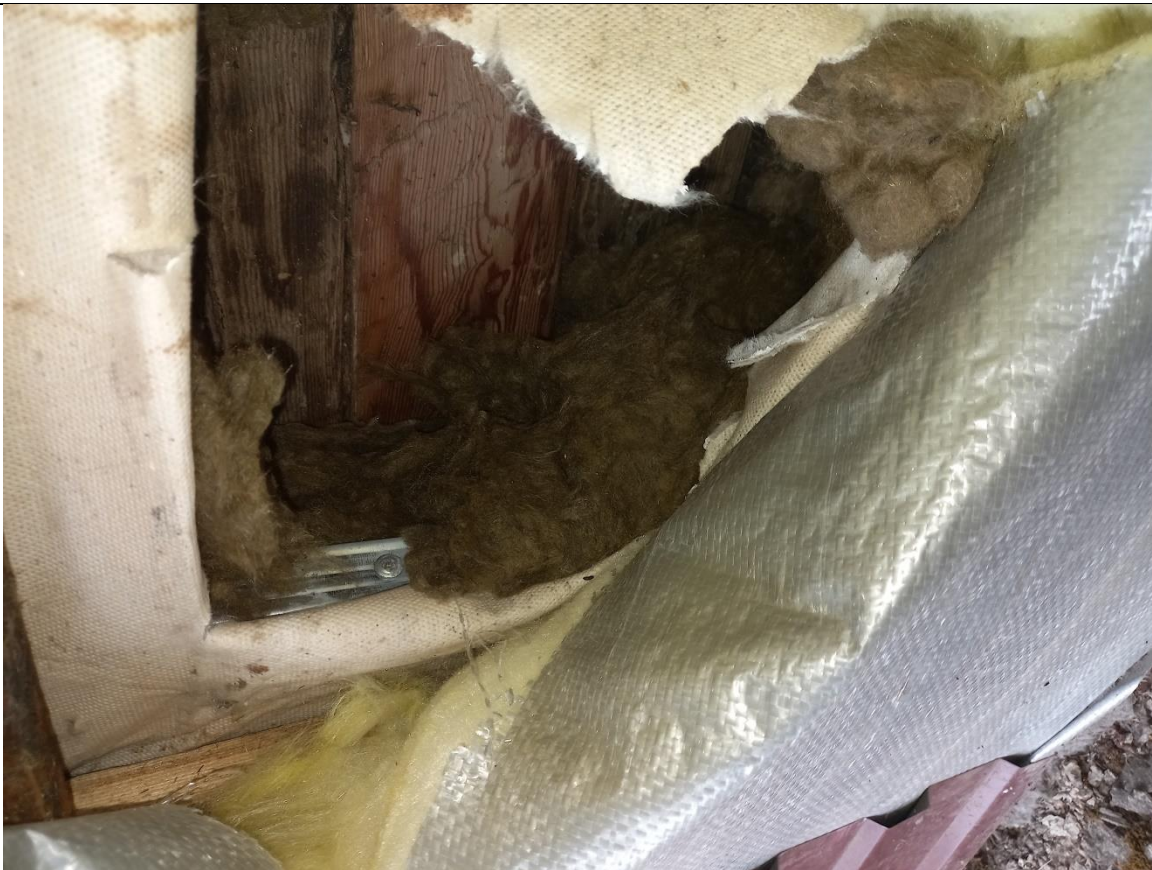
Фото 6. Фрагменты фасада в осях 6-1. Физический износ утеплителя стен, слеживание, недостаточная толщина утеплителя.
